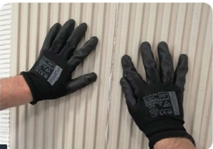
Fot.4 ŁĄCZENIE PANELI
