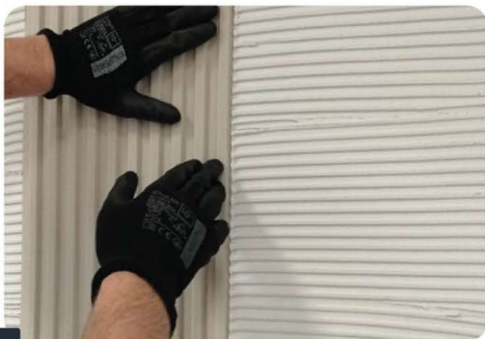
Fot.2 NAKLEJANIE PANELI
