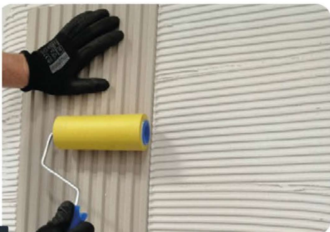
Fot.3 DOCISKANIE PANELI WAŁKIEM
