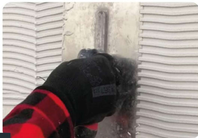
Fot.1 NAKŁADANIE MASY KLEJĄCEJ
